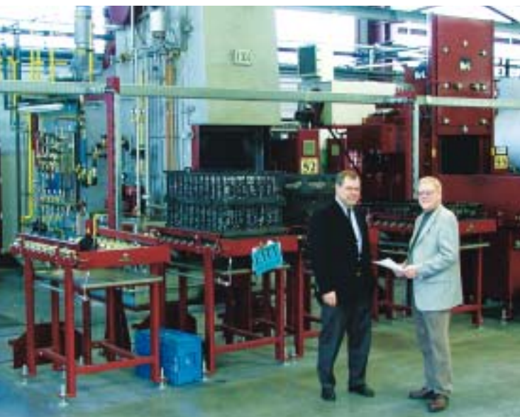
Med underskrevet indkøbskontrakt, står Fabrikschef Finn Meldhede (th) sammen med adm.dir. Karl-Josef Schmidhofer, IVA (tv), foran samme type beskyttelsesgasanlæg som kommer til Haustrups.
