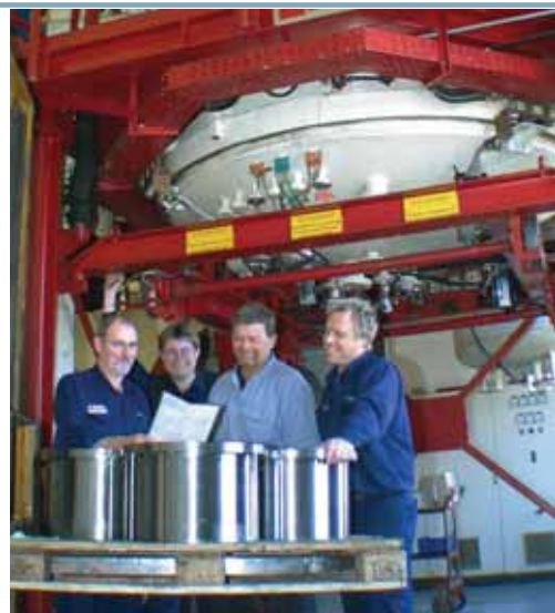
Efter veloverstået renovering og indkøring, viste ovnen sig at overholde alle de fordrede krav til bl.a. temperaturnøjagtighed. Fra højre er det Ruddi Andersen, reparatør Peter Dyhrberg Christensen som har ydet en stor indsats i forbindelse med renoveringen. Derefter fabrikschef Kell Andersen og Bengt Hansson som kontrollerer at kalibreringen er OK, inden ovnen tages i drift igen.
